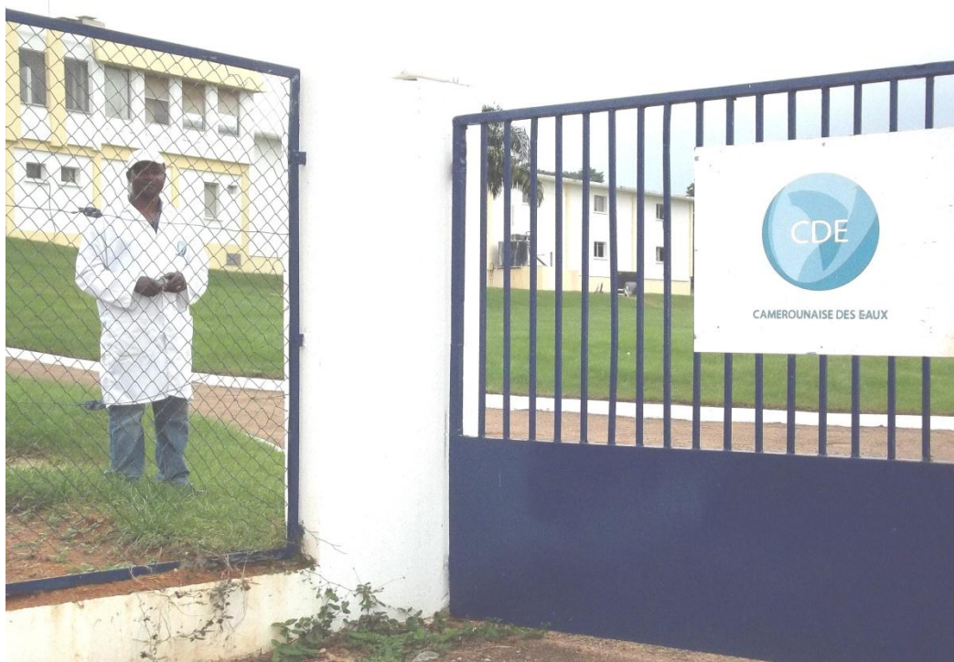
Entrée de la station de production d'eau potable d'Akomnyada
