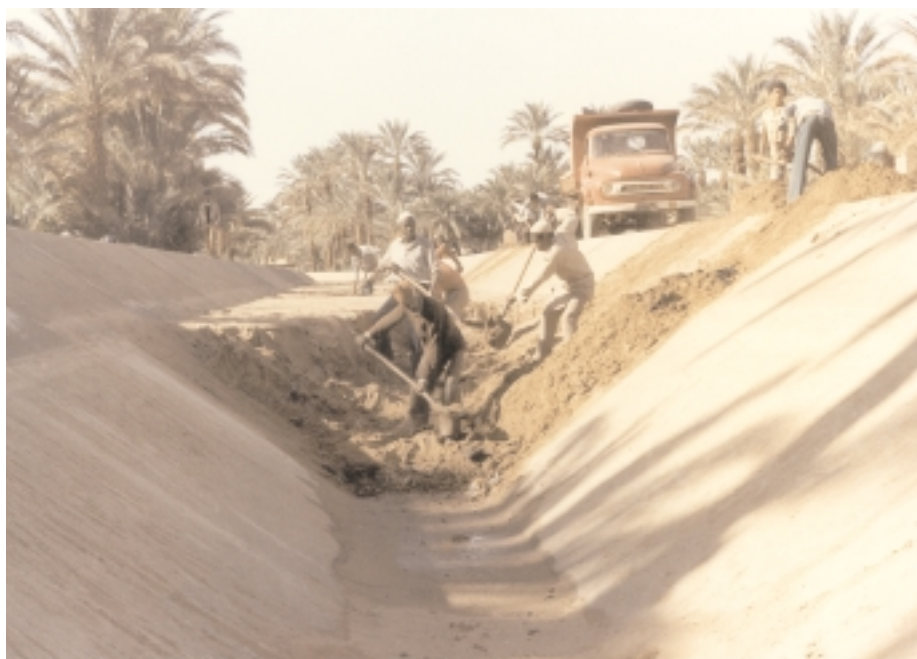
restauration de canaux d'irrigation ensablés
